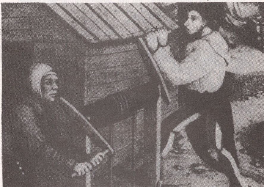
Handhaspel mit zwei entgegengesetzten Hörnern. Sie dienten im Bergbau ober- und unterirdisch zur Kohlenförderung und wurden von 2 Personen bedient.
