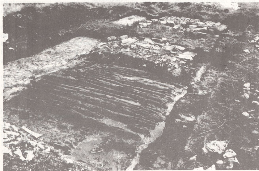
Fig. 53. Vues de l'empierrement et de l'infrastructure en bois de la chaussée.
