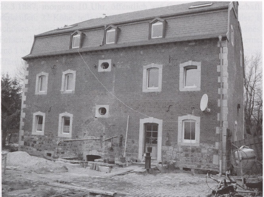
Dem Dachgeschoss wurde durch eine zusätzliche Gaube mehr Licht zugeführt. Im Erdgeschoss sind die Spuren der Überdachung der Kellertreppe noch zu erkennen (Aufn. 2008).
