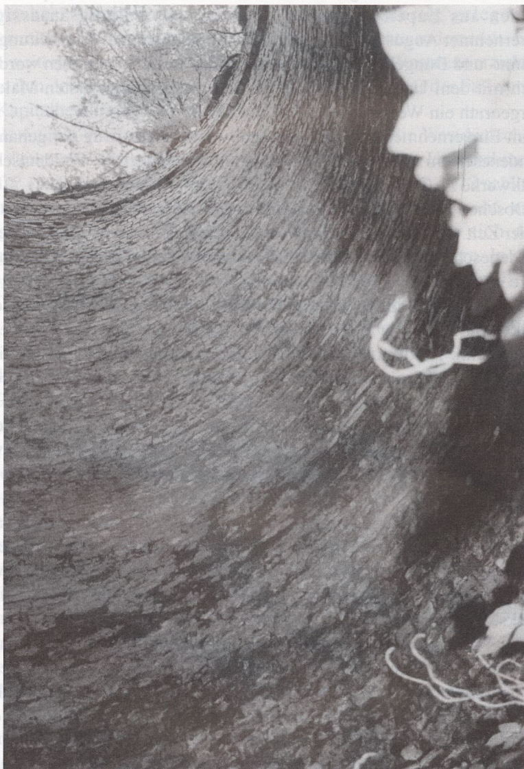
Blick in das Innere eines Ofens. Die Öfen haben einen Durchmesser von \pm 5,50 m.
