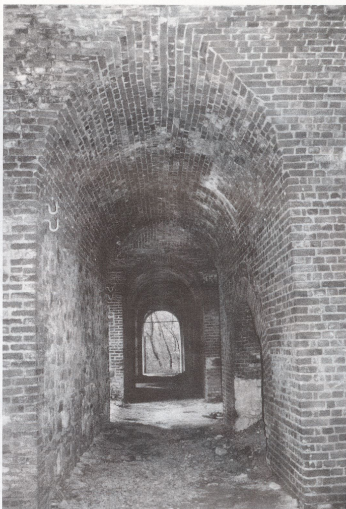
Die Öfen bestehen durchweg aus gut vermauertem Ziegelwerk. Die Anlage ist am Fuße \pm 48 m lang und 16 m breit.
