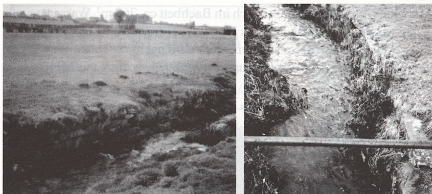
Das mit Bruchsteinen eingefasste Bachbett der Iter
