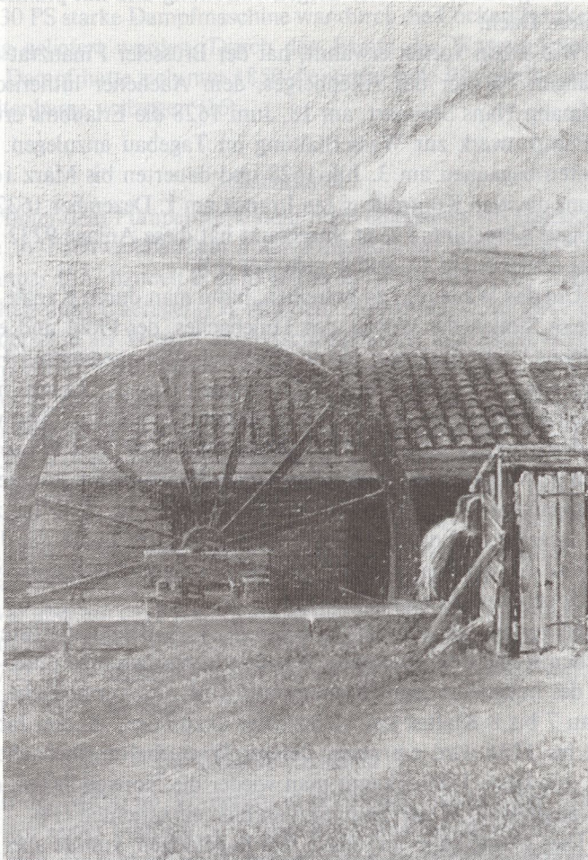
Das große unterschlägige Wasserrad
