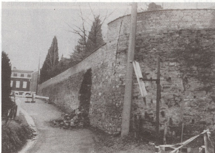
Die einsturzgefährdete Mauer, die 1986 durch eine Betonmauer ersetzt wurde
