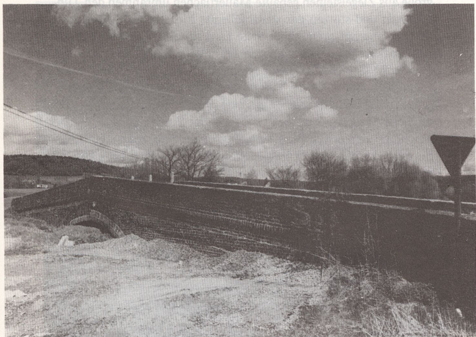
Die Schrubbel-Überführung in Völkerich. Hier ist die Bahnlinie inzwischen durch Anschüttung nivelliert worden.
