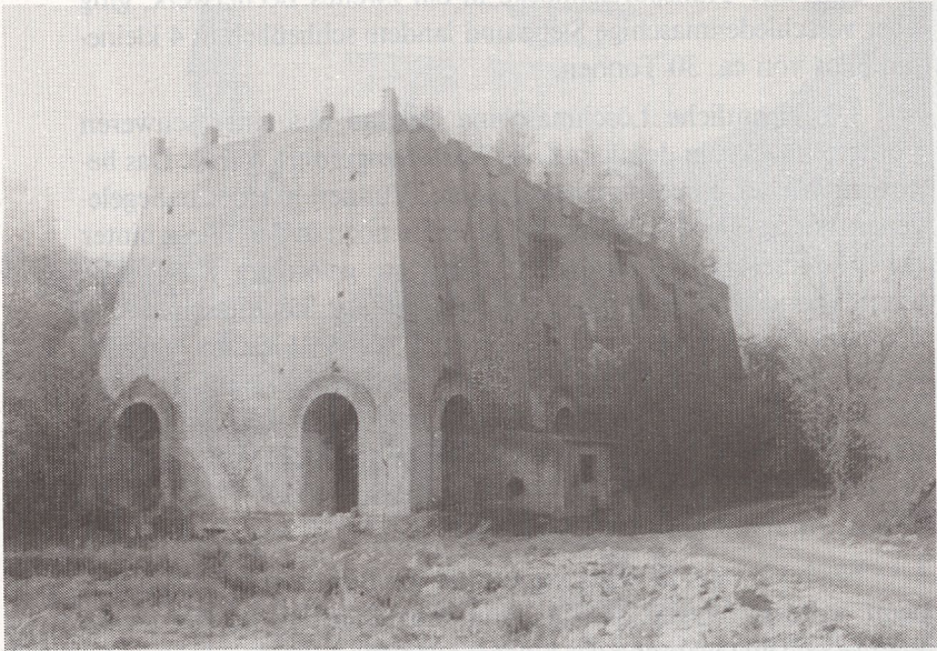
Die Öfen. Der Bau hat am Fuß eine Länge von 48 u. eine Breite von 18 m. Die Höhe beträgt etwa 13 m. Die Dicke der Außenmauern beträgt 2 m; die Öfen haben einen Durchmesser von 5 m.
